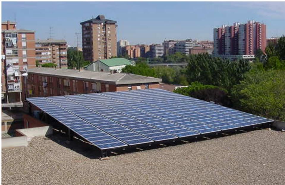
La potencia pico total es de 20.160 Wp, posee tres inversores monofásicos montados en configuración trifásica, con una potencia nominal total de 15 KW, siendo la producción de energía anual prevista de 23074 kWh.
